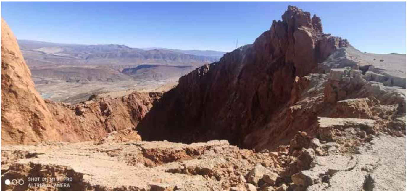
En la cúspide del Cerro Rico, el hundimiento No. 3, será mitigado con relleno seco, para devolver solidez geológica a la montaña.
