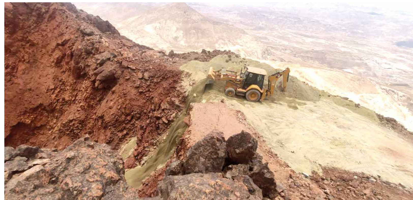
La pala mecánica de la Gobernación de Potosí, trabaja a diario, echando al hundimiento tres, relleno seco para mitigar la incidencia geológica en la cúspide del Cerro Rico.
