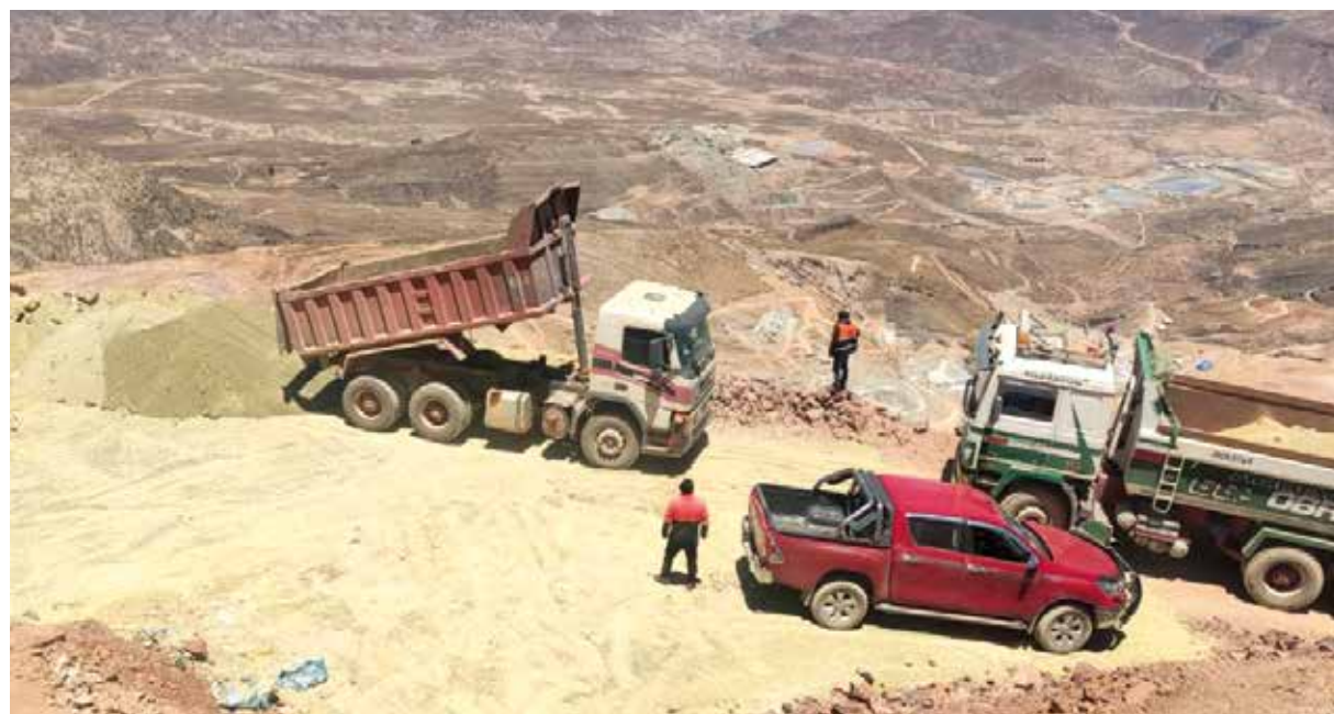
Ingenieros en Geología y técnicos de la COMIBOL y Gobernación, día a día, coordinan trabajos orientados a echar relleno seco al hundimiento No. 3 para mitigar la incidencia geológica.
