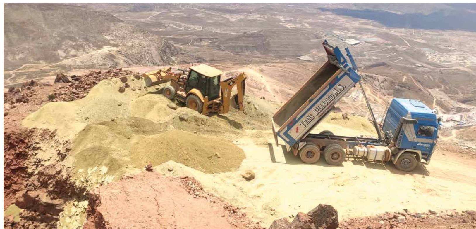
Maquinaria pesada consistente en volquetas de 18 toneladas y palas mecánicas llevan decenas de material rocoso seco para depositar en la incidencia geológica No. 3.
