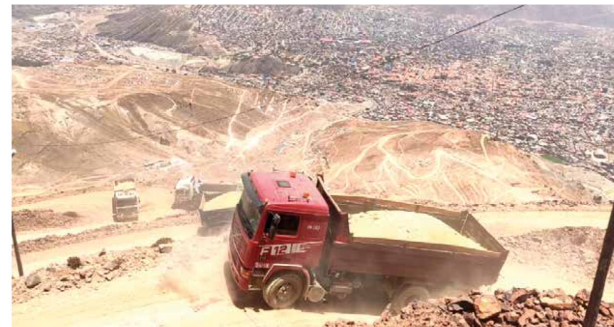
A diario desde el pasado 31 de octubre, una columna de volquetas de alto tonelaje, trasladan relleno seco para depositar en el hundimiento No. 3. Los rodados transitan aproximadamente 9 kilómetros desde la base Pailaviri en las faldas del macizo rocoso.
