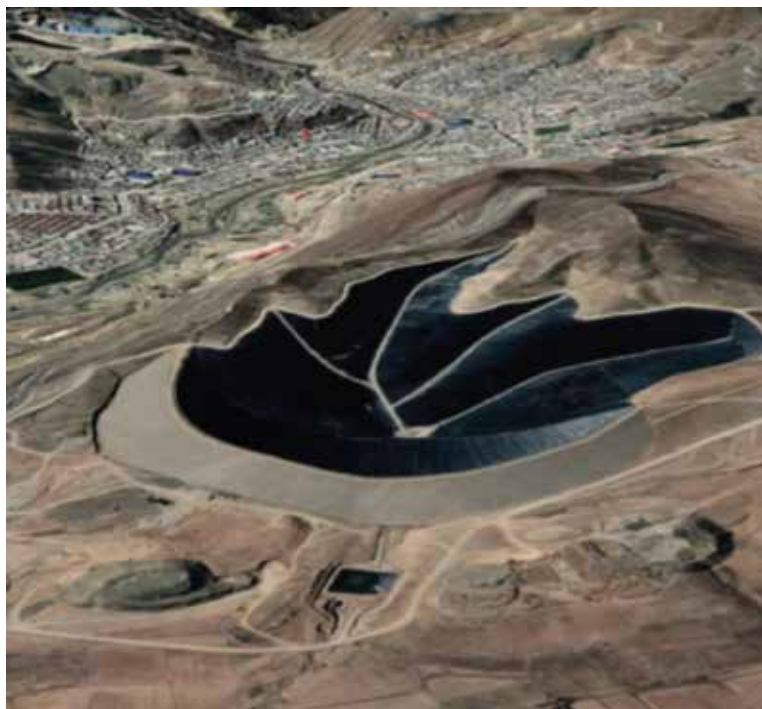
Dique de colas Willa Kholu – Empresa Minera Huanuni
