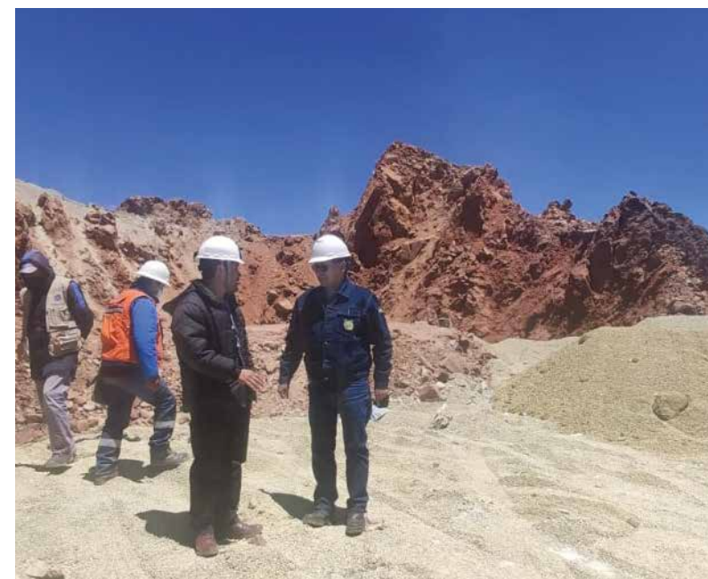
El Presidente Ejecutivo de la COMIBOL, Ing. Marcelino Quispe, realiza una inspección al plan de intervención minera con relleno seco en el hundimiento No. 3, en la cúspide del Cerro Rico
