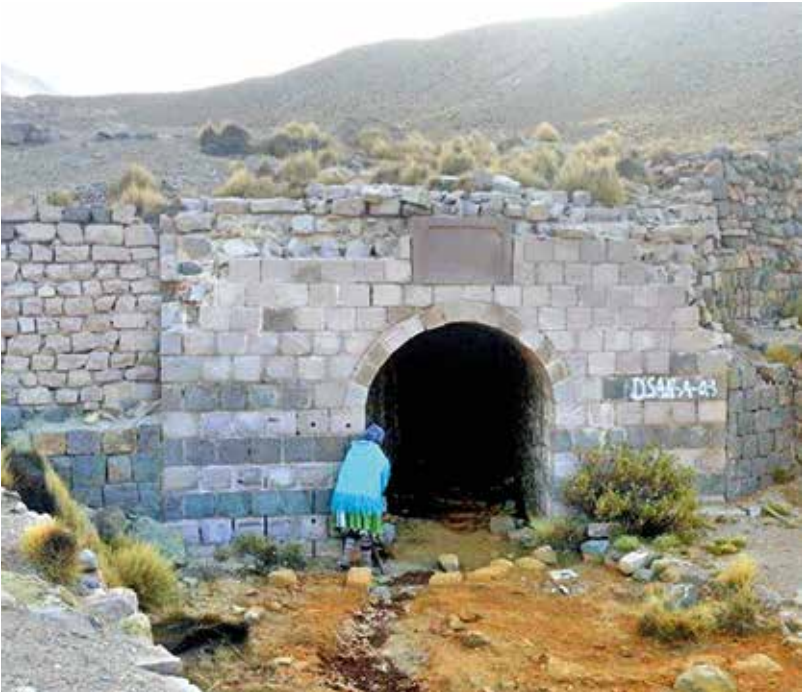
Vestigios del antiguo asentamiento minero.
