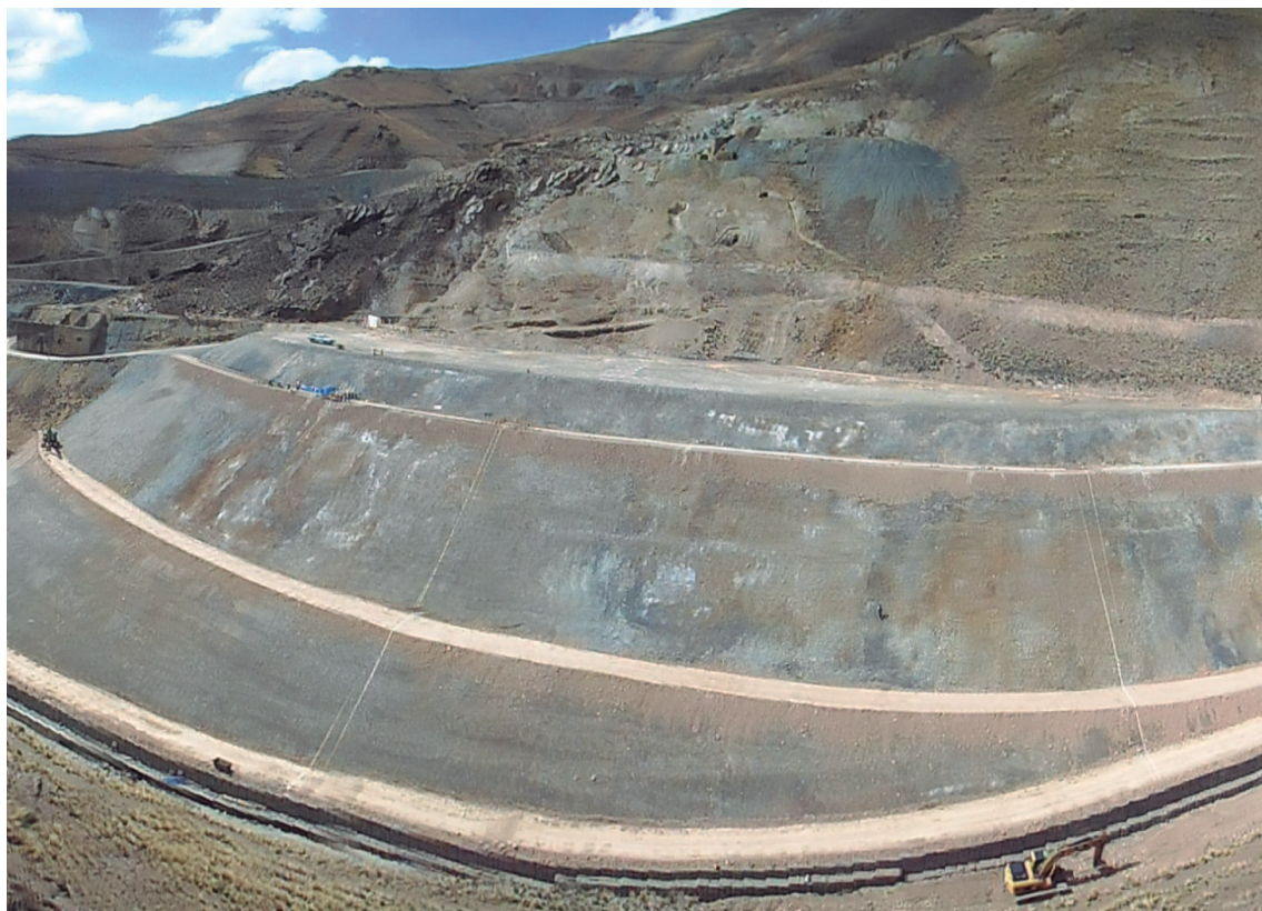
Dique de Colas de la mina Bolívar
