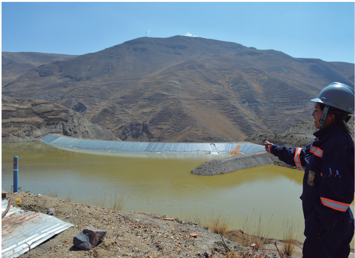
Dique de colas de la Empresa Minera Colquiri.
