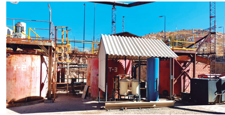
Parte de la planta en la metalúrgica de Karachipampa.
