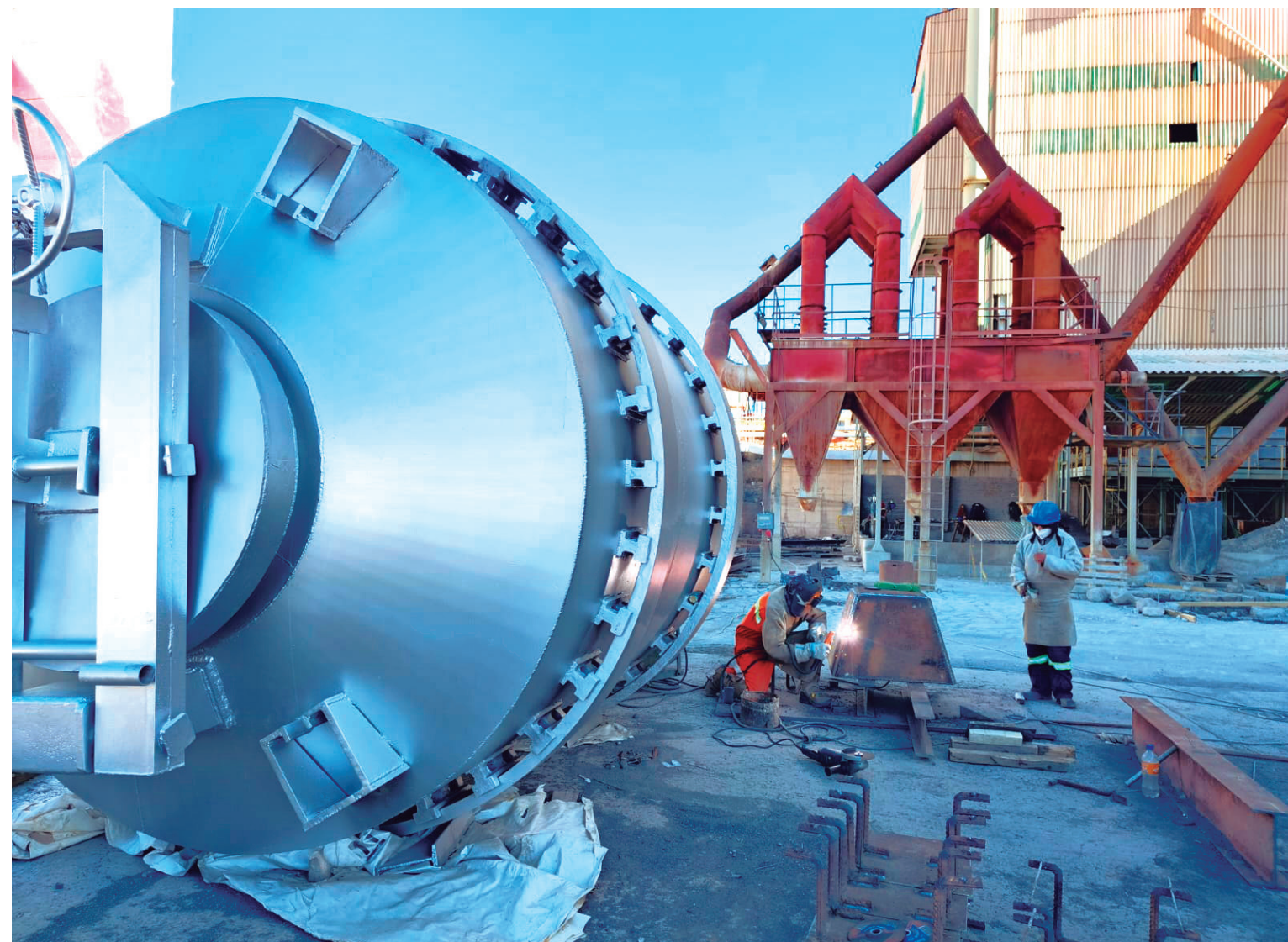
Instalación del nuevo horno rotatorio para aumentar la fundición de plomo y plata en la Planta Metalúrgica de Karachipampa.
