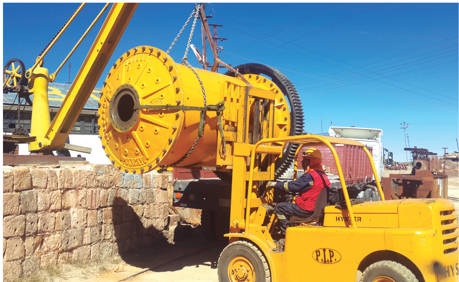
Una Montacarga recibe un molino de barras para triturar mineral fabricado en la Planta Industrial de Pulacayo.
