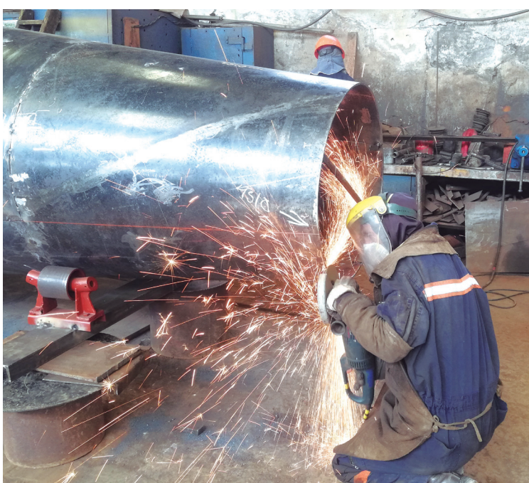
Un técnico en soldadura realiza trabajos en la Planta Industrial de Pulacayo.
