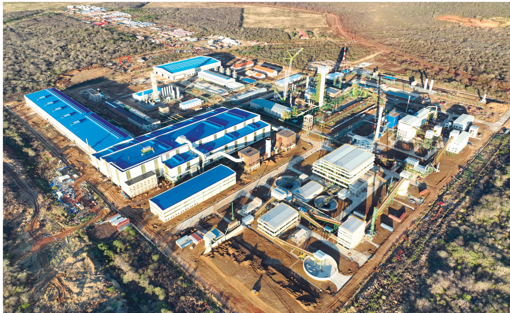
Una vista panorámica de la Empresa Siderúrgica del Mutún (ESM) en el municipio de Puerto Suárez del departamento de Santa Cruz.
