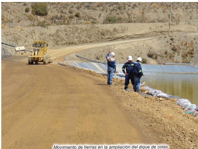
Movimiento de tierras en la ampliación del dique de colas
