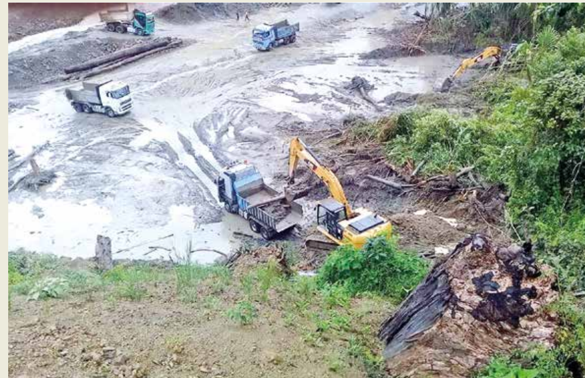
Material pesado es extraído de la poza de una cooperativa aurífera por retroexcavadoras.
