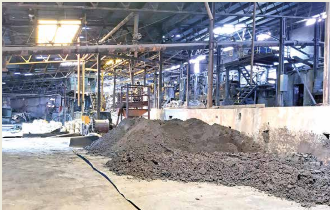
Interior de la Planta de Fundición de Telamay.
